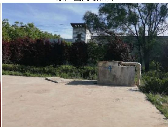
东厂区消防水池
