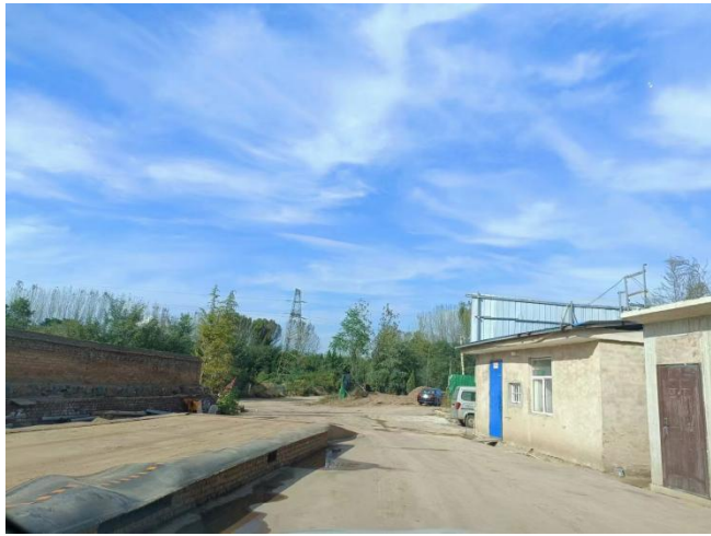
项目厂区入场道路
