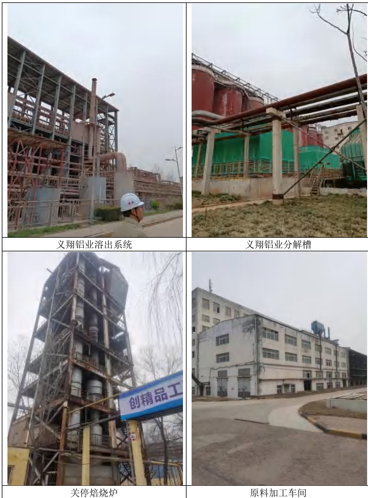
图 3.3-4 依托工程现场图片
