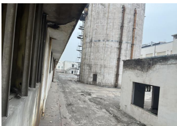
1#焙烧车间及输送廊道现状
