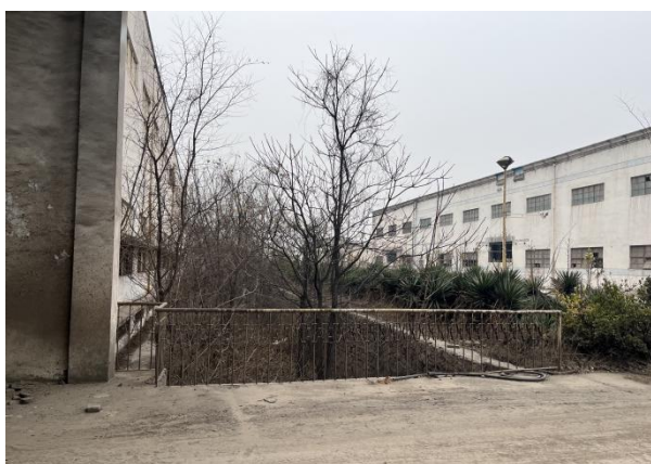
项目占地北侧现状
