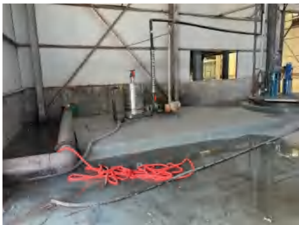
车间内储水池（地下）
