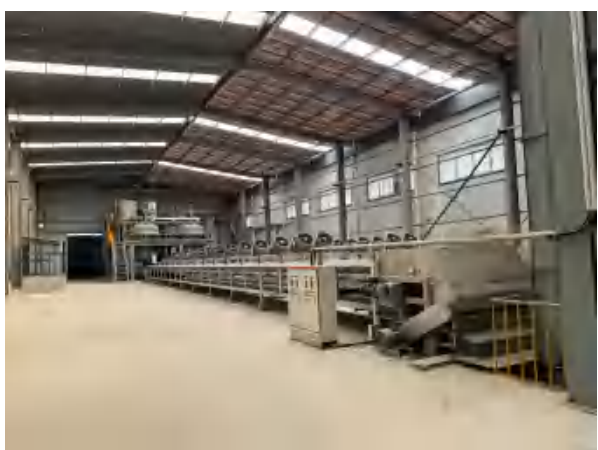
生产车间内部（反应罐、冷却机、破碎机等）
