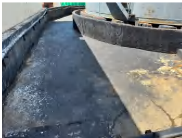
罐区围堰（现有工程）
