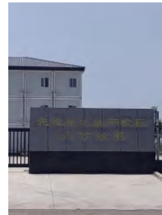
开发区人才公寓（厂区北侧）
