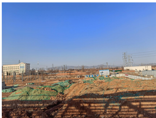
项目北侧 昌泰净水剂项目（在建）
