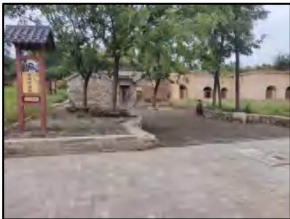
安特生旧居现状照片
