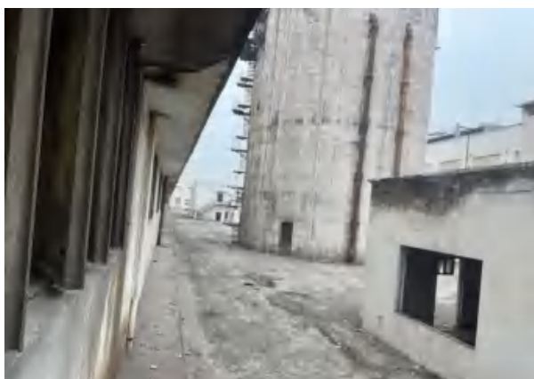
1#焙烧车间及输送廊道现状
