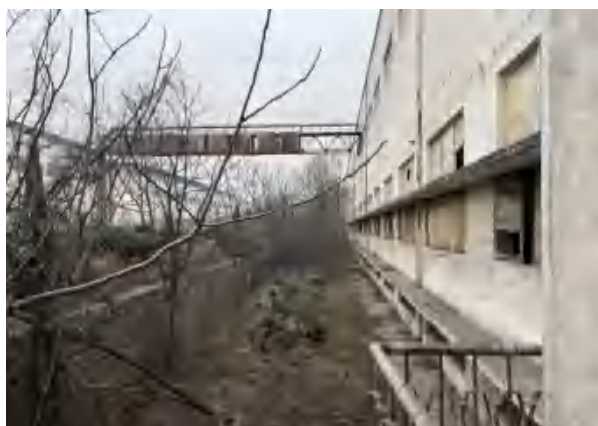
项目占地南侧现状
