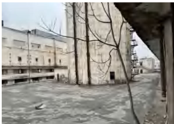
2#焙烧车间及输送廊道现状
