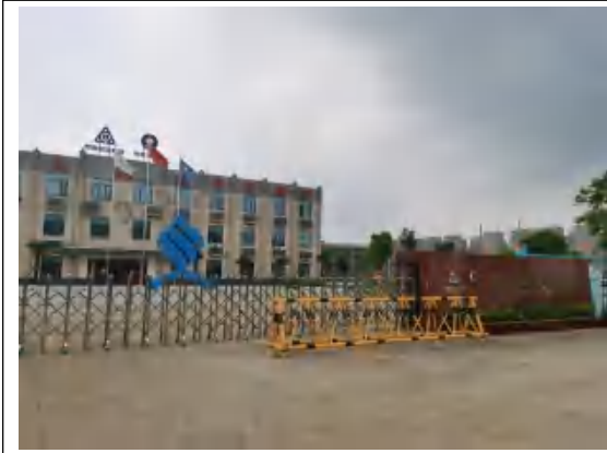
豫西 LNG 应急储备中心
