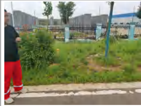
项目起点顶管穿越入口
