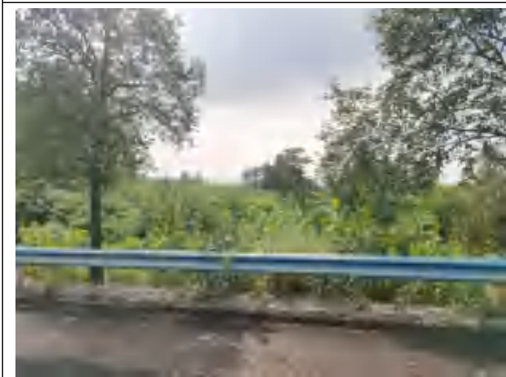
穿越 310 国道入口
