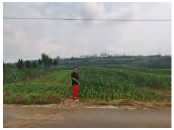
乡道顶管穿越出口
