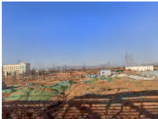
项目北侧 昌泰净水剂项目（在建）
