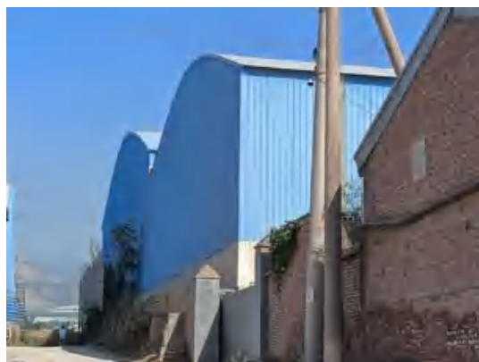
厂区北侧 破碎料厂
