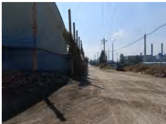
厂区西侧 园区道路
