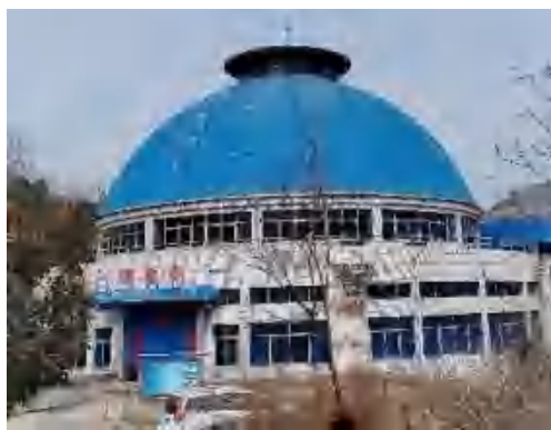
一级泵站屋面
