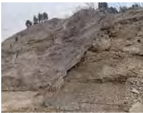
三级泵站护坡
