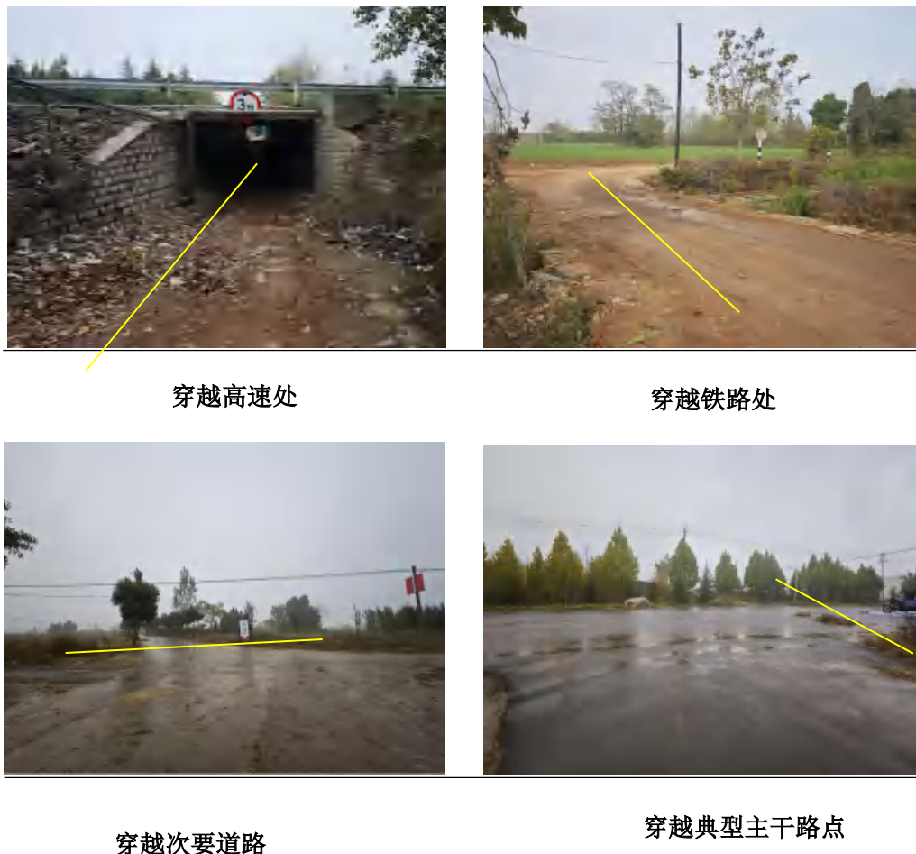
图 2.3-3 穿越工程现状照片
