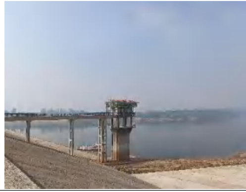
西段村水库照片
