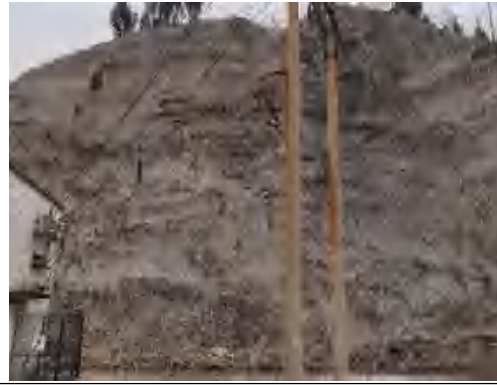
二级泵站护坡
