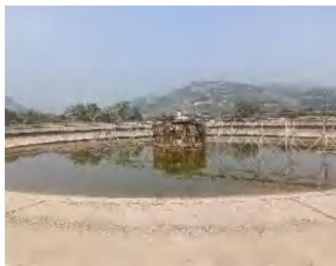
一级泵站沉淀池
