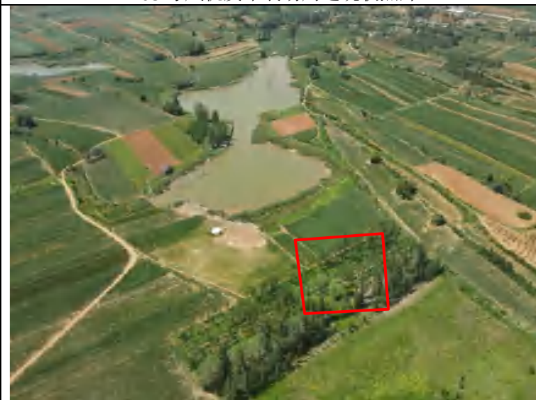
F10 号风机及吊装场周边现状照片
