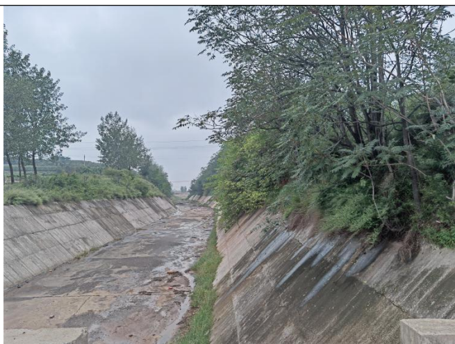
厂区南侧（泄洪渠）
