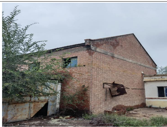
厂区拟利用一般固废暂存间
