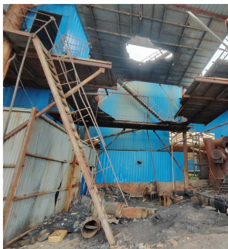
现有工程-煤气发生炉已拆除
