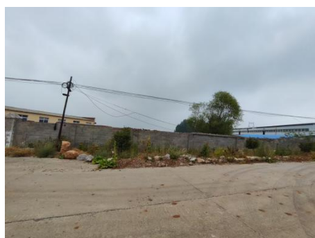
厂区南侧-道路
