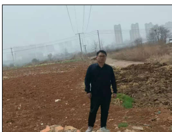
工程师现场勘查照片
