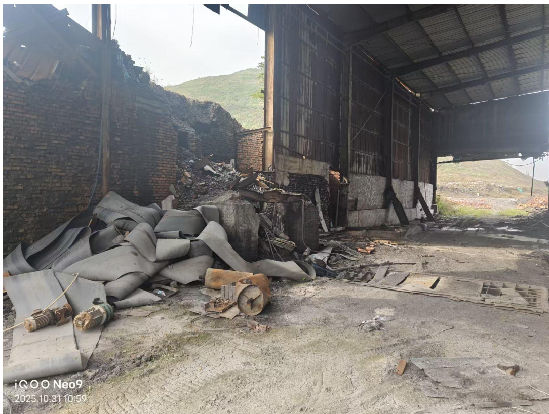
配料工段鄂破机已拆除
