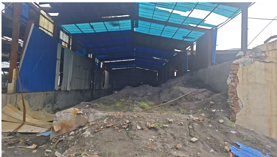
陈化车间已拆除
