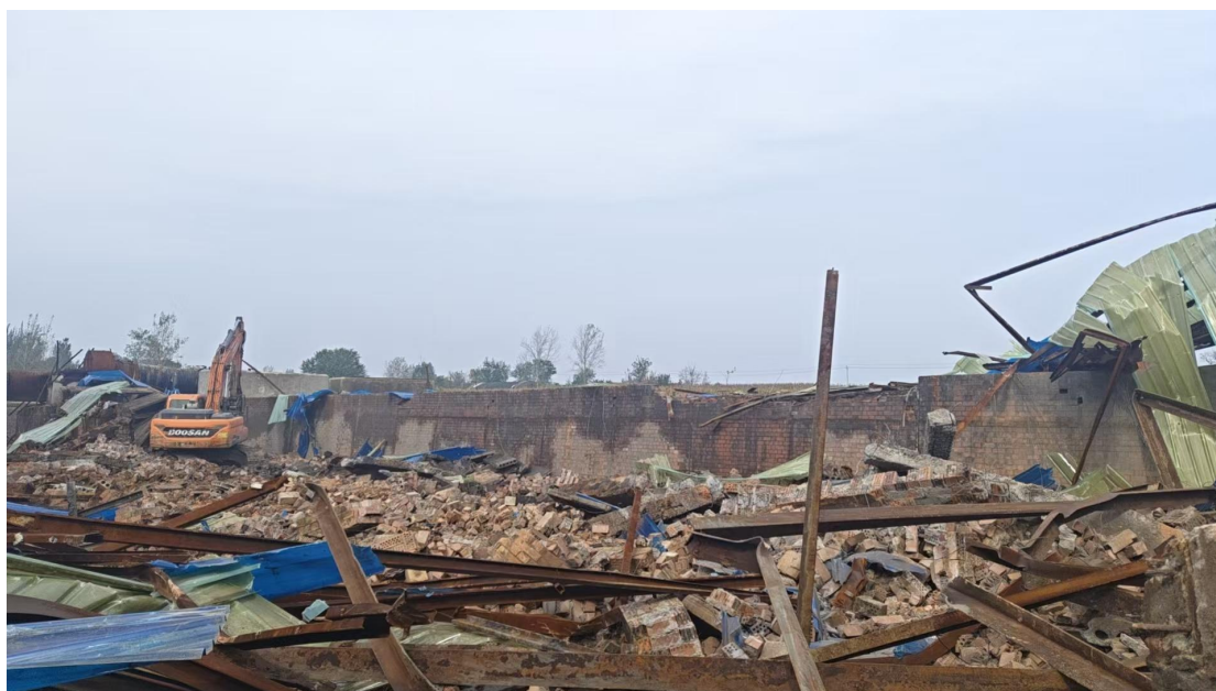
两条隧道窑正在拆除
