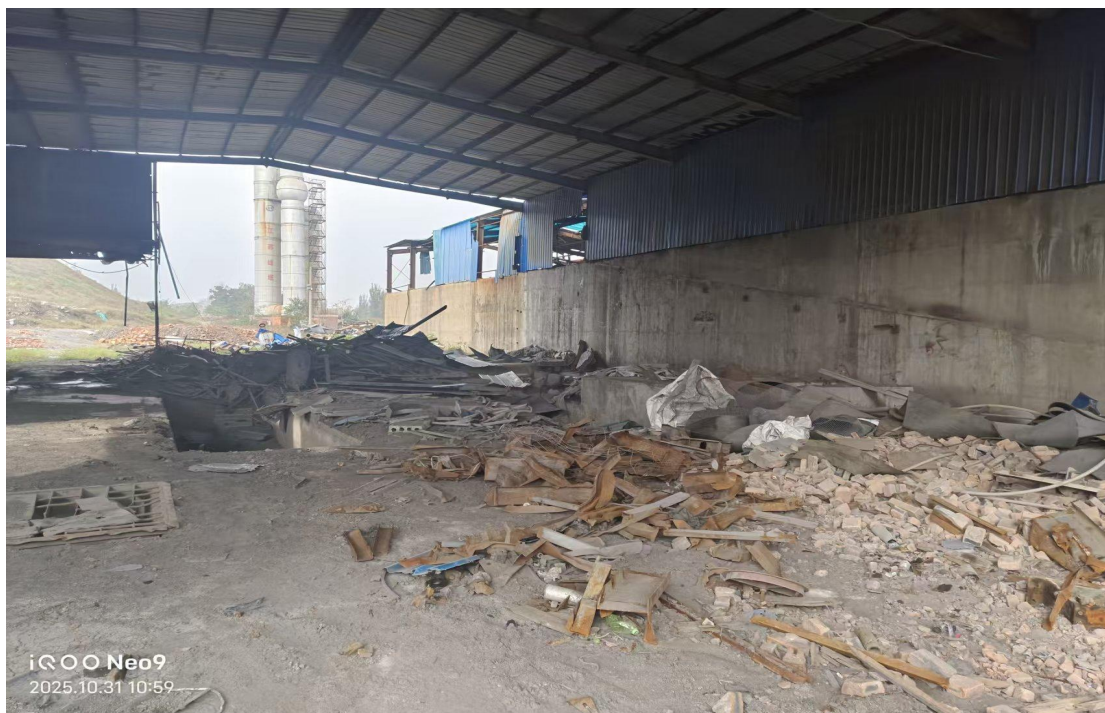
搅拌，筛分工段已拆除
