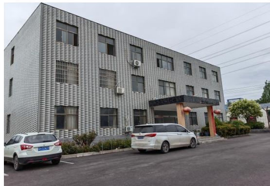
6.厂区现有办公楼
