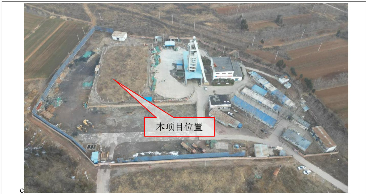
段村矿1号罐笼井采矿工业场地
