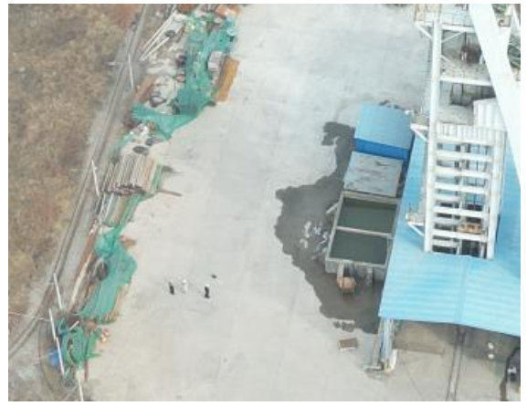
工程师勘探现场
