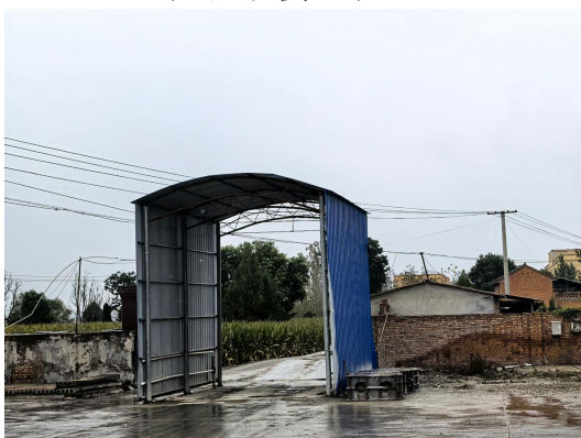
厂区车辆冲洗装置
